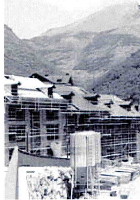
Obras realizadas por Martins Fadesa.
